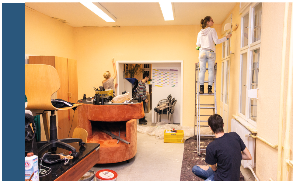
Das Jugendforum beim Renovieren in der „Alten Post“
